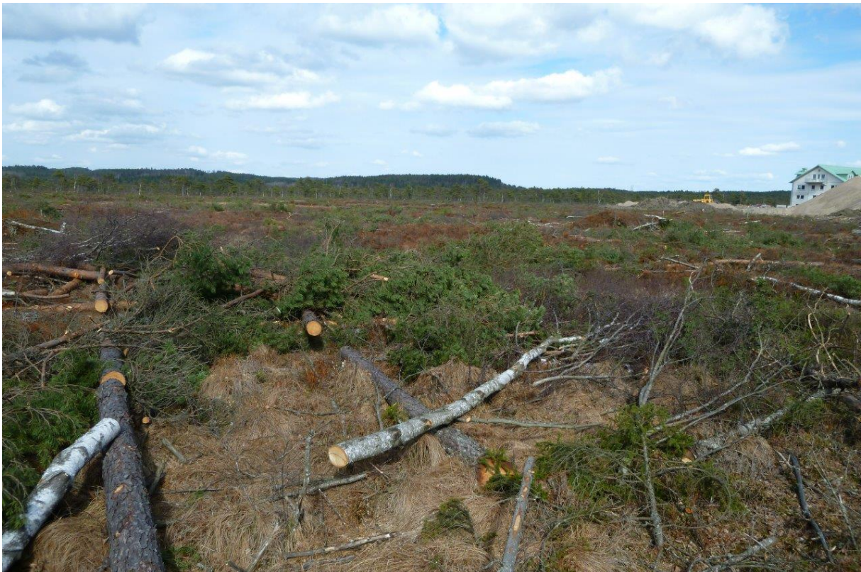
Nyligen avverkad sumpskog på Kollanda mosse samt påbörjad täckning med schaktmassor. Foto Roy Jansson, 2013-04-28.
