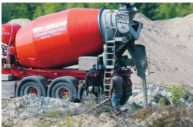
2011 polisänmälde kommunen företaget efter att bilder tagits när de höll på att tippa flytande betong i mossen från en av företagets bilar och med cementgjuteriets ägare vid bilen.
